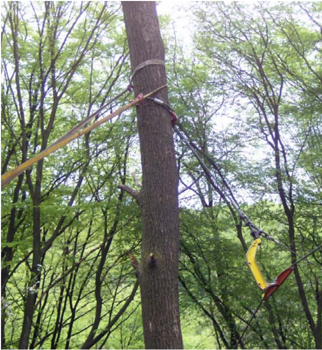
Abb. 5.11: Umlenkung des Tragseils über eine Hangkante
