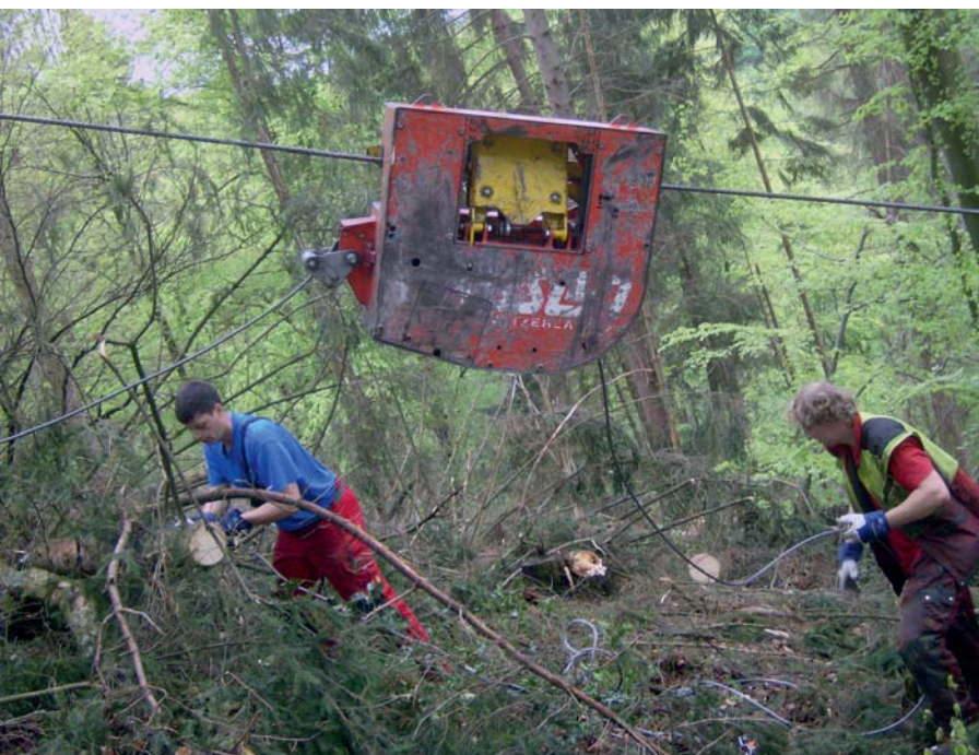
Abb. 5.13: Seilkränrückung im Steilhang
