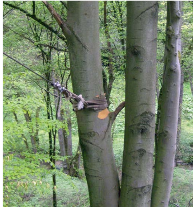
Abb. 5.12: Tragseilabspannung am unteren Trassenende
