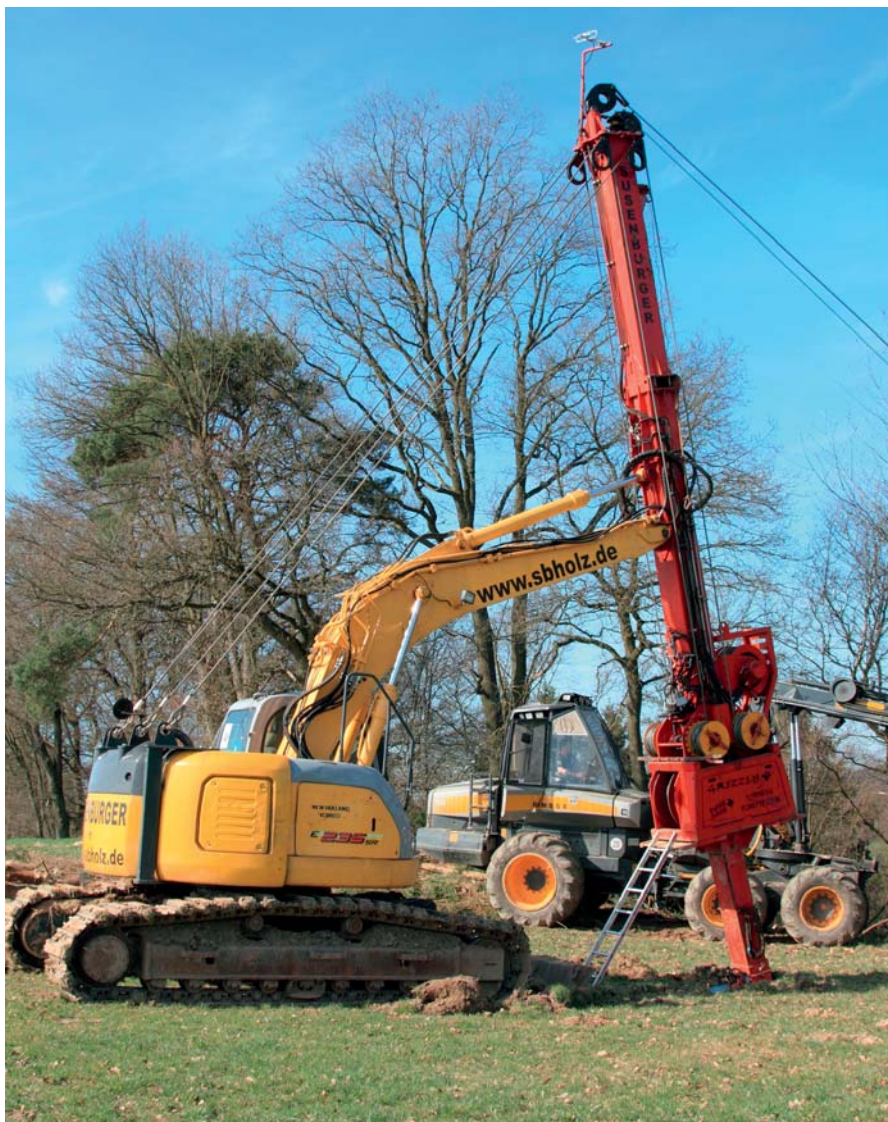
Abb 5.10: Bagger mit Seilkranmast am oberen Trassenende
