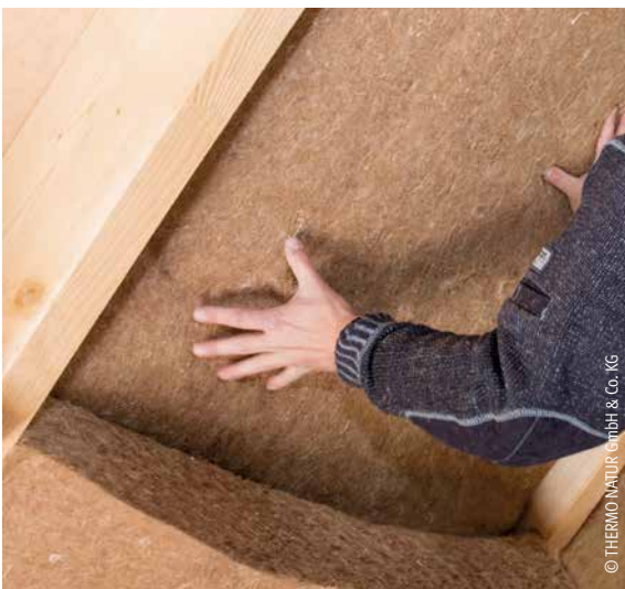
Einbau einer flexiblen Jute-Dämmmatte
