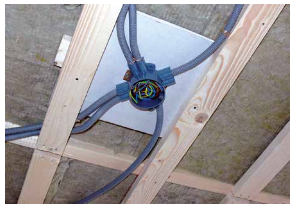
Detailplanung: Elektroverteilerdose in Deckenkonstruktion
