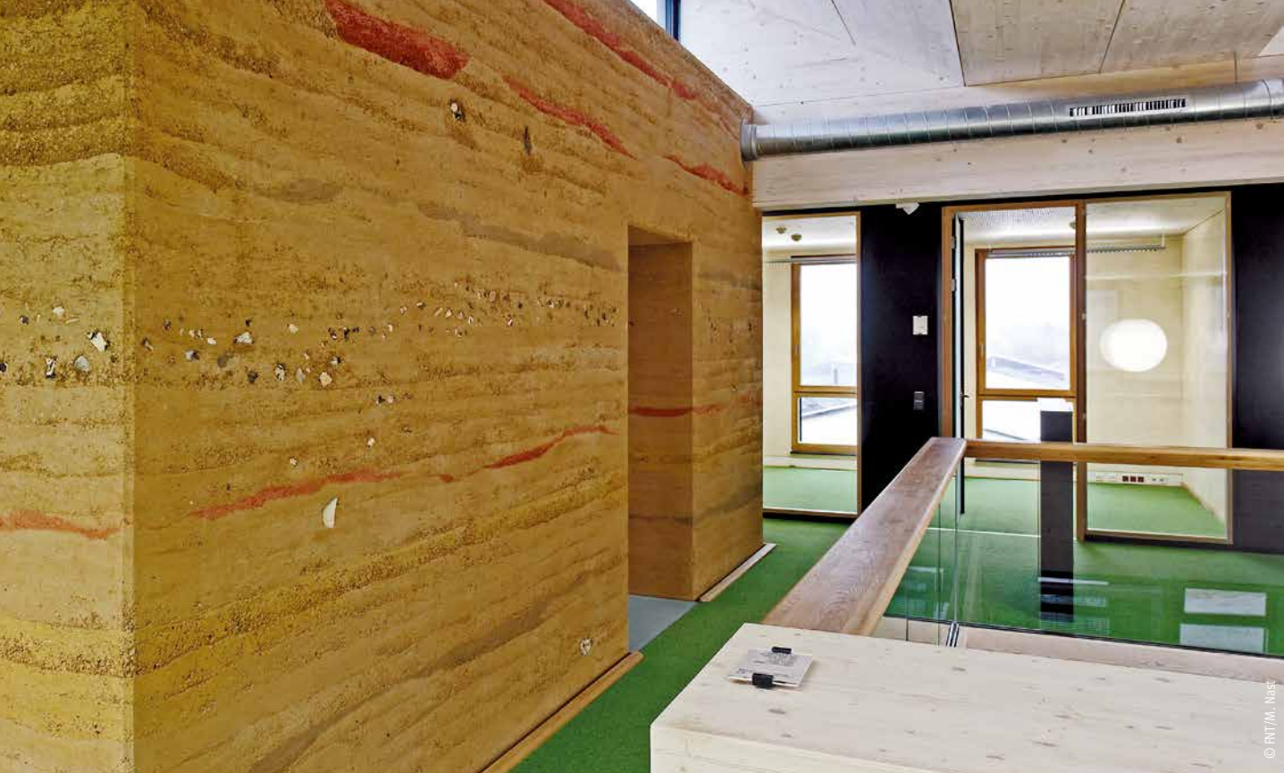
Stampflehmwand im FNR-Neubau: Unterstützer des Holzbaus in Sachen Innenraumklima
