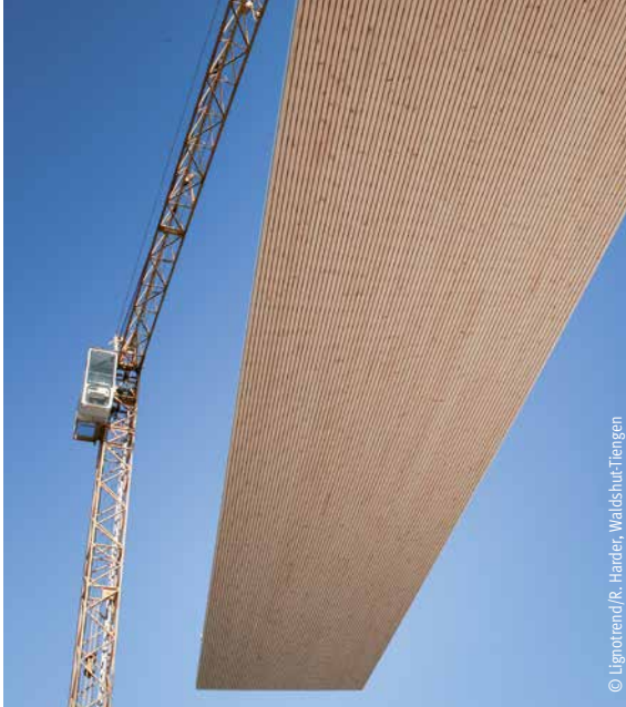
Montage eines Holzmassivbauteils mit integrierten Absorbern
