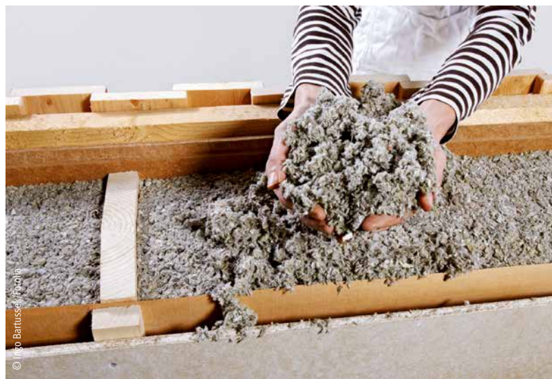
Beispiel einer Wanddämmung mit Zellulosefasern
