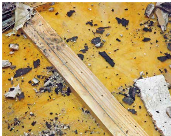
Brandversuch für eine Deckenkonstruktion in Holzbauweise (oben: Versuchsanordnung; unten: Deckenbalken nach 60 Minuten Brandbelastung)
