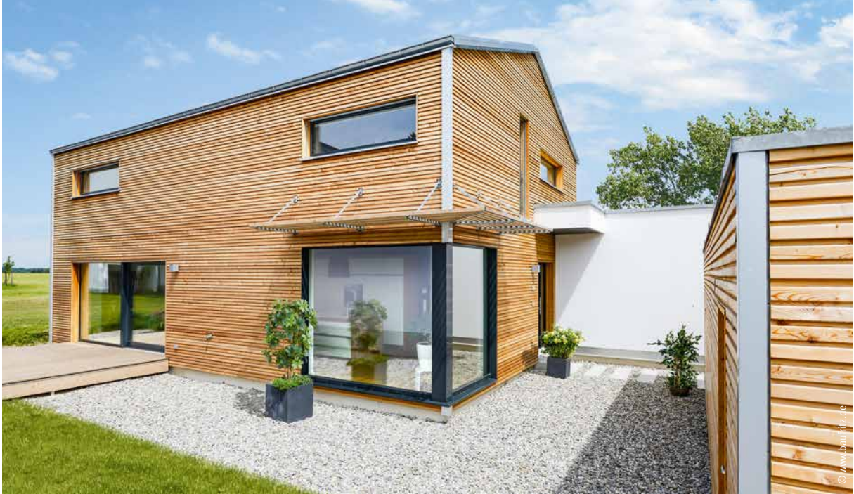
Einfamilienhaus in Holzrahmenbauweise
