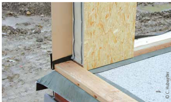
Bauteilstoß mit eingelegtem Dichtungsprofil
