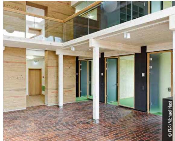
Materialkombinationen schaffen Speichermasse im Holzhaus
