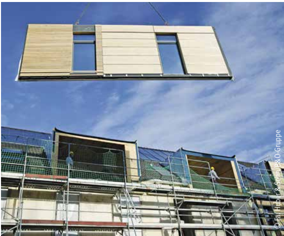
Sanierung des ehemaligen Kasernengebäudes in Bad Aibling mittels vorgestellter Holzrahmenelemente
