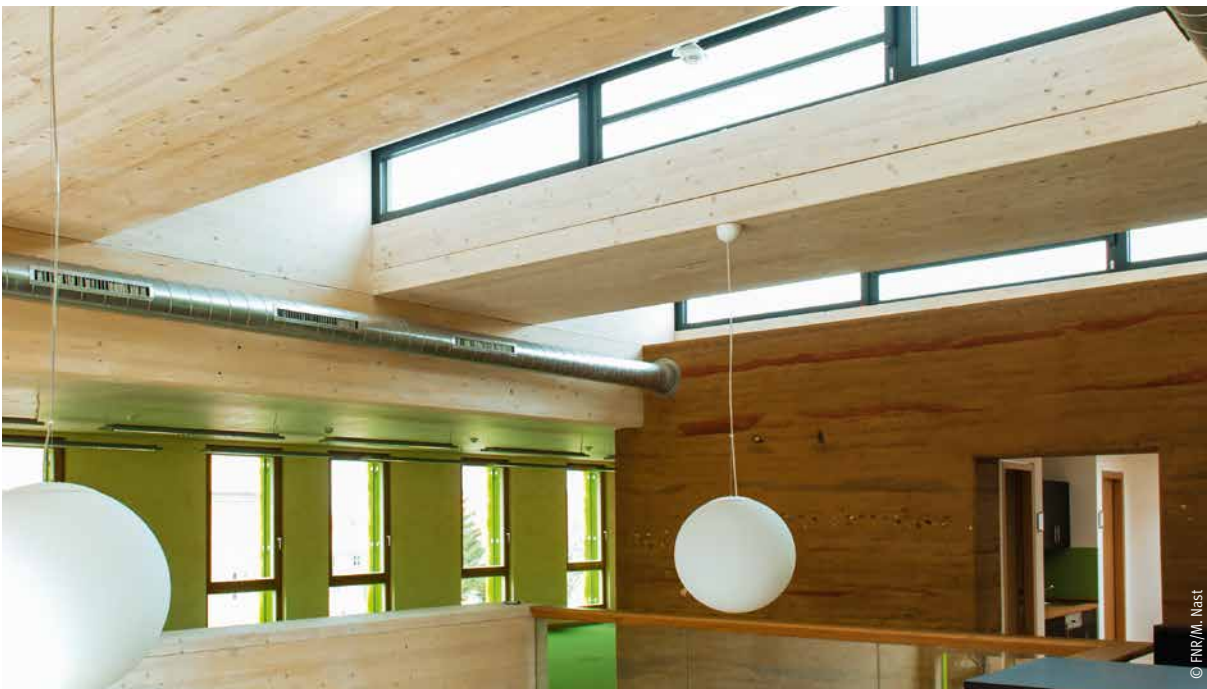
Sichtbare Brettstapelelemente im FNR-Neubau
