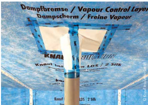
Dichte Leitungsführung durch die Luftdichtung
