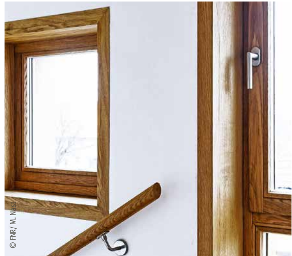
Innenausbau im Holzbau
