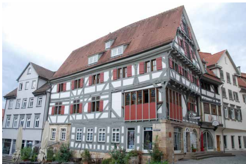
Saniertes Fachwerkgebäude am Hafenmarkt in Esslingen
