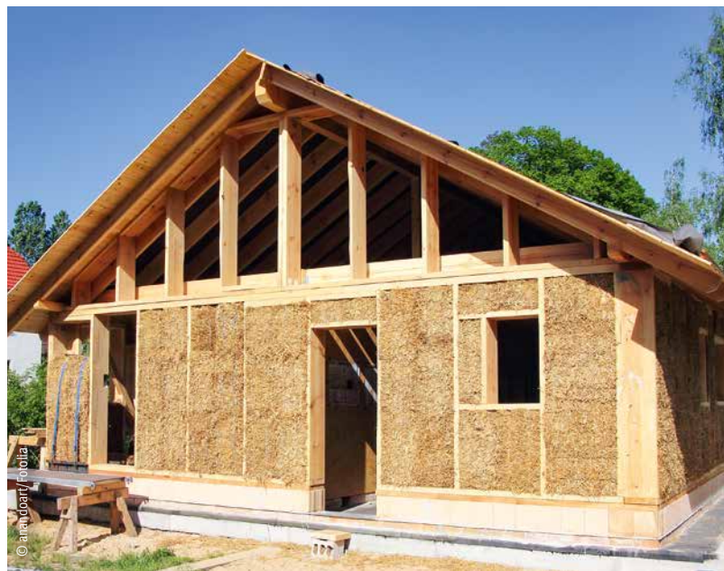
Holzrahmenbau mit Strohdämmung
